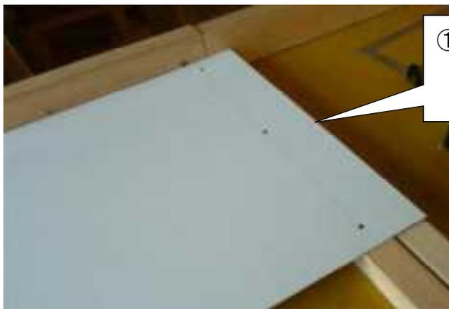
①相手コートとの2×2材の端に合板にあわせ、自分のコートとの2×2材にネジ止め
