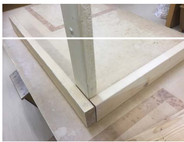
スタートエリアの反対側に、2×4材を写真の向きにコーススレッド等で取り付ける。
